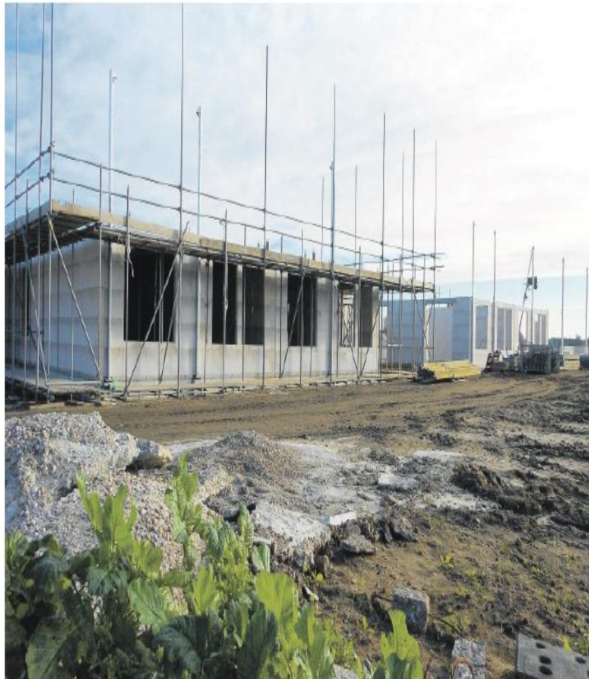
▲ Work in Progress, voortgang nieuwe Hoge Veer.
