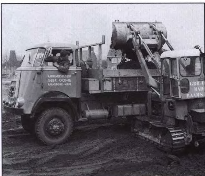
- De werknemers van de aannemerscombinatie Gebr. Oome c.v. en Van Erp en Zoon hadden hun handen vol aan de grondwerkzaamheden.
