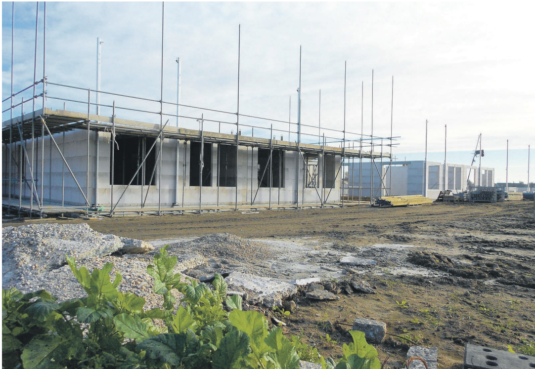
▲ Work in Progress, voortgang nieuwe Hoge Veer.
